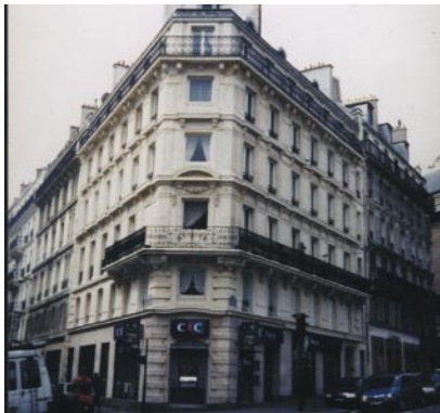
Typisches Gebäude in der Pariser Innenstadt: Entfernung mehrlageriger Farbschichten mit LEU Paste CW
